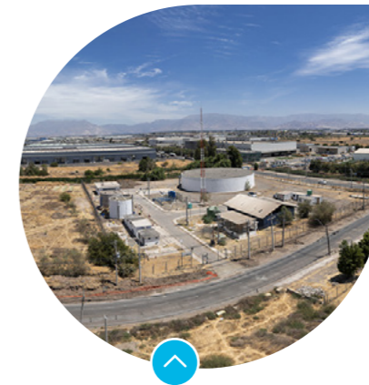
Planta Agua Potable Lo Pinto.
