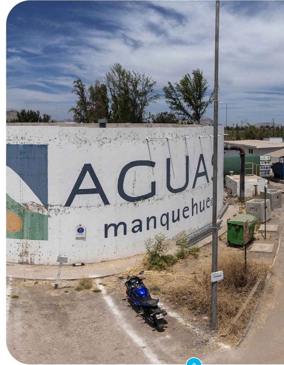
Planta Agua Potable Alto Lampa, Lampa
